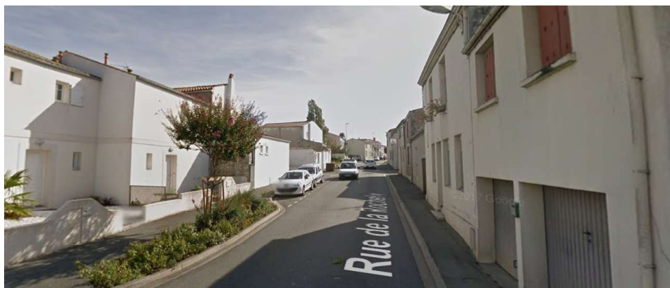
Saint-Xandre : voie double sens, stationnement longitudinal d'un seul côté, trottoirs plantés
