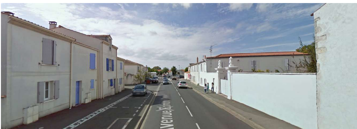
Aytré : voie double sens, stationnement longitudinal d'un seul côté de la voirie, pas d'aménagement cyclable, trottoirs.
