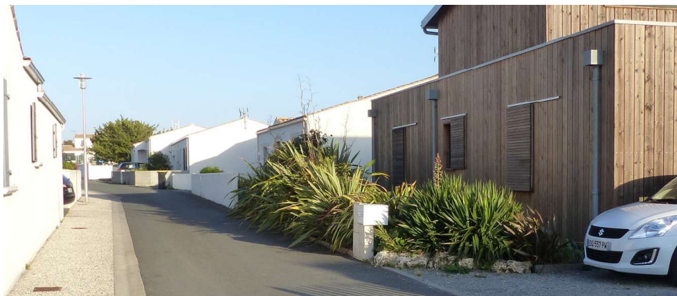
La Jarrie : voie sens unique, accotement étroit d'un seul côté de la voirie, parcelle privée avec espaces plantés
