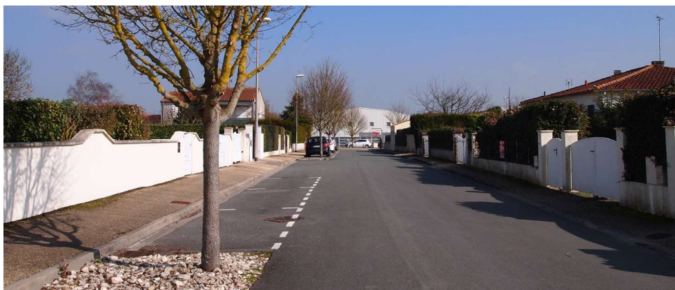
La Jarrie : voie double sens, stationnement longitudinal planté d'un seul côté, trottoirs étroits
