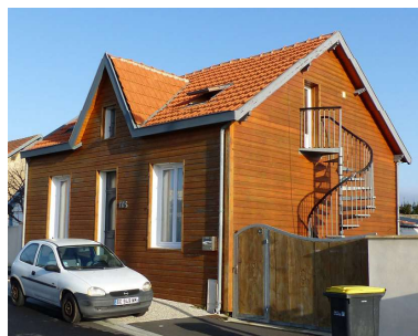
Exemples de bardages posés sur du bâti balnéaire dénaturant les façades et empêchant les murs en pierre de respirer
