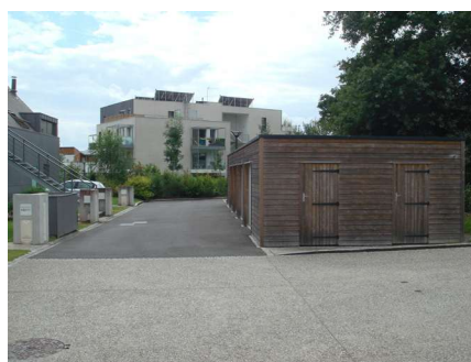
Exemple de regroupement de garages et locaux techniques avec un traitement qualitatif
