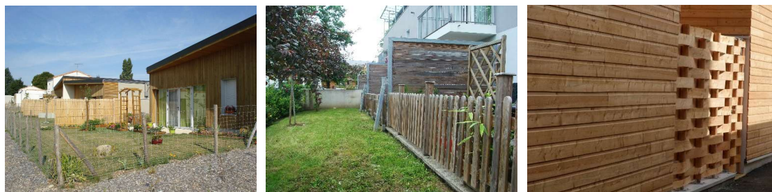
Exemples de systèmes de claustras bois permettant, sur un linéaire le long de la terrasse, de préserver l'intimité des habitants
