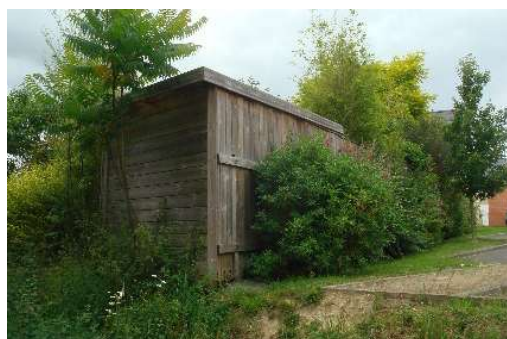
Exemple d'une annexe à l'habitat bien intégrée dans son environnement
