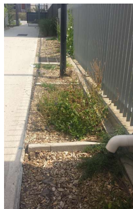
Exemple de descentes des eaux pluviales vers une zone d'infiltration, un caniveau ou une cuve de récupération des eaux pluviales - Source : Urbanwater
