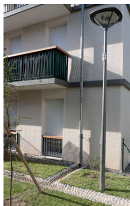
Exemple de descentes des eaux pluviales vers une zone d'infiltration, un caniveau ou une cuve de récupération des eaux pluviales - Source : Urbanwater
