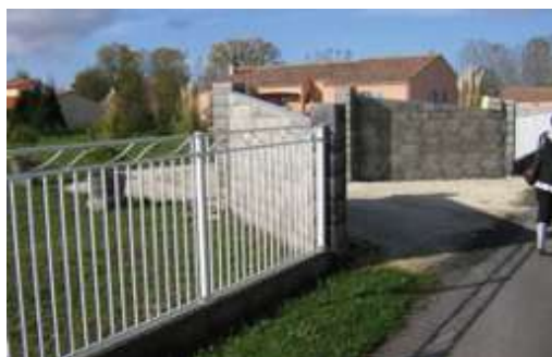
Portail implanté en retrait par rapport à la clôture dont les retours sont composés d'imposantes maçonneries disproportionnées par rapport à la clôture : à éviter
