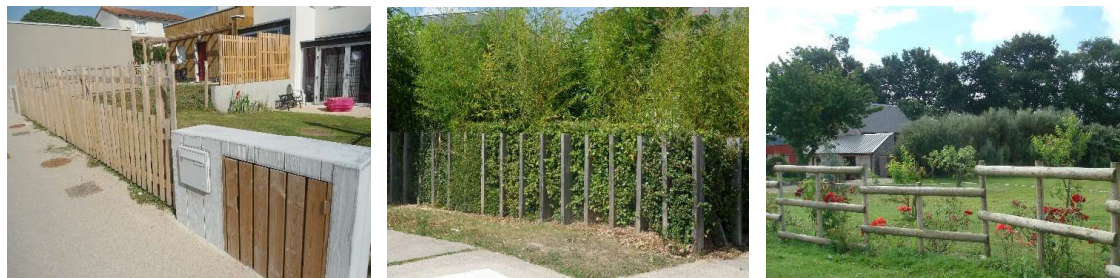
Exemple de clôtures dans un contexte plus rural : les clôtures se feront plus légères et favoriseront les matériaux naturels tel que le bois ainsi que les dispositifs à claire-voie
