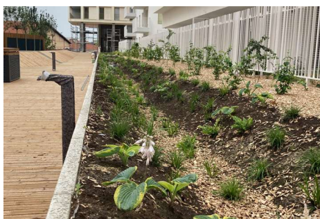
Exemple d'une noue sur dalle en cœur de quartier Asnières-sur-Seine - Source : Urbanwater
