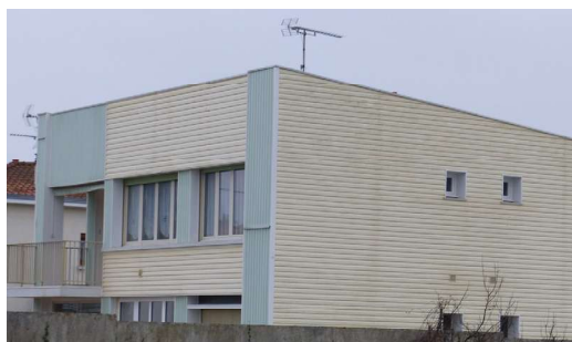
Exemple d'un bardage portant atteinte à la qualité architecturale d'un bâti des années 1950
