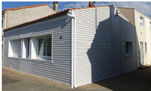
Exemples de bardages posés sur du bâti traditionnel dénaturant les façades et empêchant les murs en pierre de respirer
