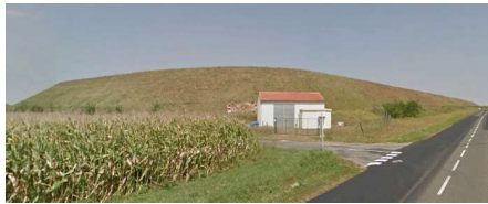
Exemple à éviter : réserve d'eau non intégrée paysagèrement Source : Google Maps
