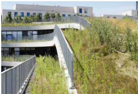
Exemple de toiture végétalisée - école des sciences de la Biodiversité - Boulogne-Billancourt - Source : Ekopolis
