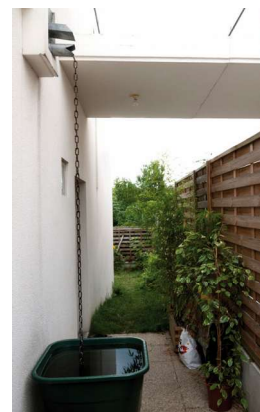
Exemple de descentes des eaux pluviales vers une zone d'infiltration, un caniveau ou une cuve de récupération des eaux pluviales - Source : Urbanwater
