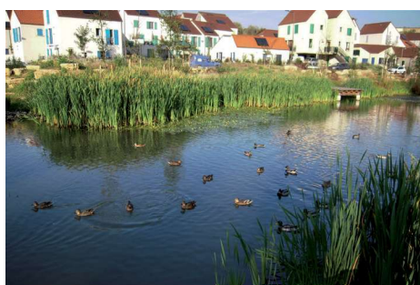
Exemple d'un bassin assurant la collecte des eaux pluviales - Auxerre Source : Urbanwater
