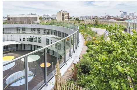
Exemple d'une cours de récréation en toiture - école du chemin vert d'Aubervilliers - Source : Endroits en vert
