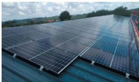
Les ateliers techniques et la caserne des pompiers sont recouverts depuis l'origine par des panneaux en fibrociment. Des travaux de désamiantage vont commencer le 18 novembre prochain. Les panneaux existants seront remplacés par des bacs acier adaptés afin de recevoir dans un deuxième temps des panneaux photovoltaïques.
