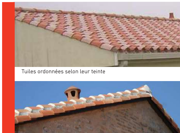
Les rives ne doivent pas être débordantes sur les pignons
