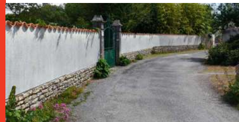
Mur bahut surélevé
