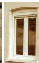
Volets roulants et fenêtre non adaptée à la baie
