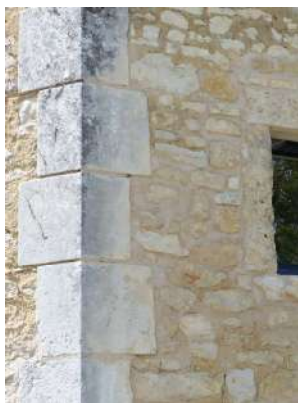
Chaînage en pierre de taille et enduit à pierre vue sur une façade de dépendance
