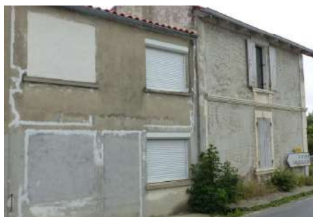
Le percement d'ouvertures aux proportions non adaptées
