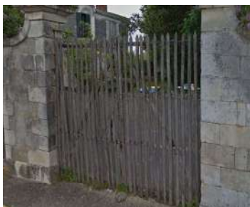
Portail en bois à lames verticales
