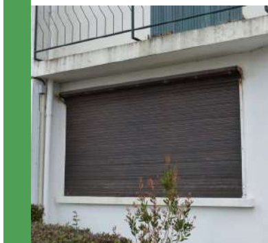
Baie large et volets roulants en bois
