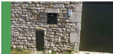
Percement bordé d'un chaînage en pierre
