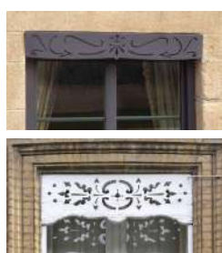
Lambrequins dissimulant un coffre de volet roulant disgracieux ancien
