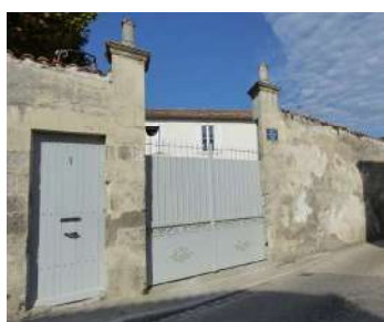
Portails ouvragés anciens en ferronnerie (partie basse pleine et partie haute ajourée)
