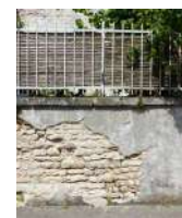
Grille doublée d'un brise-vue
