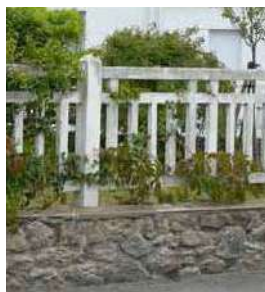
Mur bahut surmonté d'une claire-voie en béton moulé
