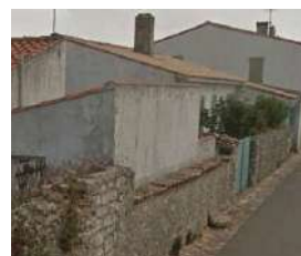
Adossements collés en retrait d'un mur ancien et traitement peu qualitatif de la construction (enduit ciment)
