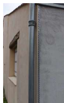
Réalisation d'un enduit ciment
