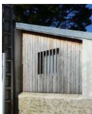
Construction contemporaine adossée à un mur ancien
