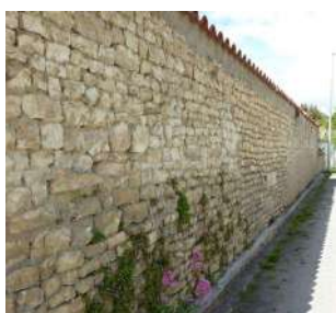
Murs en moellons recouverts d'un enduit à fleur et recouverts de tuiles
