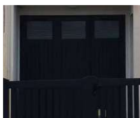
Porte en bois à lames verticales et oculi ronds ou carrés
