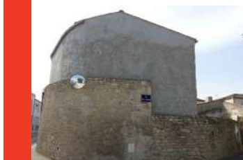
Adossements collés en retrait d'un mur ancien et traitement peu qualitatif de la construction (enduit ciment)
