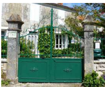
Portails ouvragés anciens en ferronnerie (partie basse pleine et partie haute ajourée)
