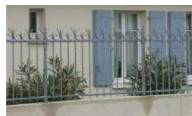
Grilles sur mur bahut, sans et avec festonnage
