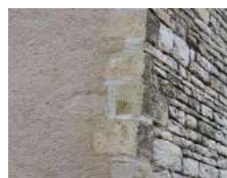
Le moellon enduit
