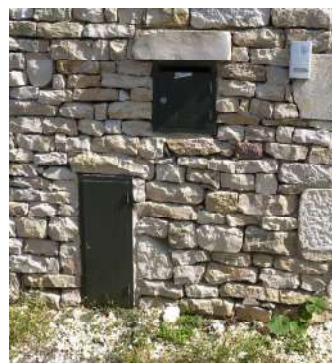
Intégration de boîtes aux lettres et de coffrets techniques dans la structure d'un bâtiment ou sa clôture
