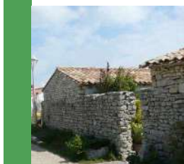
Construction en surélévation d'un mur ancien
