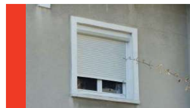
Volet roulant plastique avec coffre apparent
