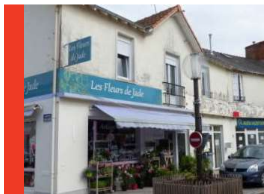
La même maison avec un élargissement du rez-de-chaussée et de nombreuses pertes de décor
