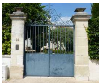
Portails ouvragés anciens en ferronnerie (partie basse pleine et partie haute ajourée)
