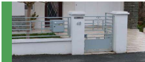
Une clôture d'origine, constituée d'un mur bahut et d'une claire-voie largement ajourée
