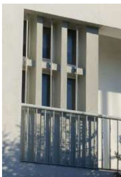
Claustra en voiles de béton verticaux
