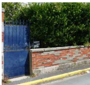
Mur bahut surmonté d'une grille
