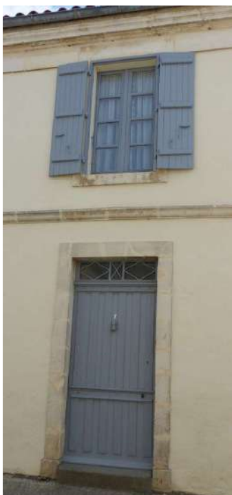
Corniche, bandeau, encadrements et seuils en pierre de taille
