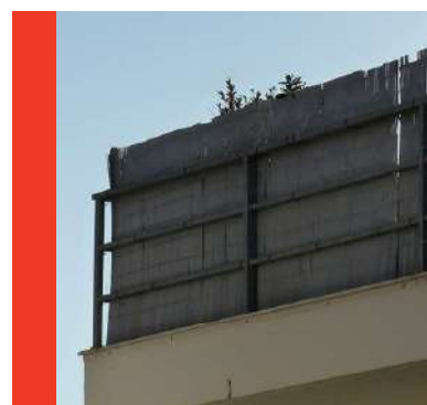
Brise-vue implanté sur un garde-corps
