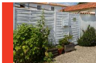
Mur remplacé par des panneaux de bois préfabriqués
