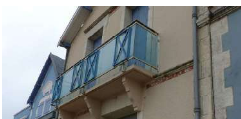
Balcon à garde-corps en bois remplacé par un vitrage
