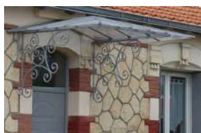
Exemples de marquises en ferronnerie
