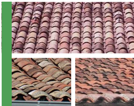
Couverture tiges de botte de teinte légèrement nuancée
