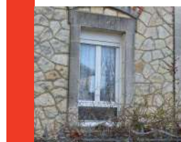
Volets roulants avec coffres apparents
