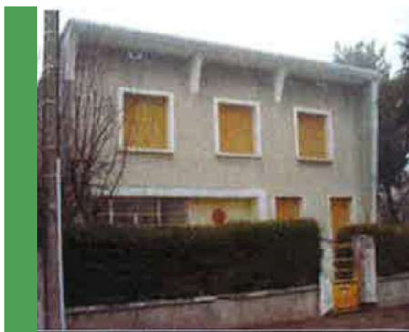
Une maison aux volets jaunes à l'origine
