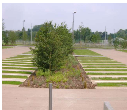
Désimperméabilisation du parking du parc Elie Lotar à Aubervilliers (image de gauche) et désimperméabilisation des sols par l'usage de pavé enherbé (image de droite)
