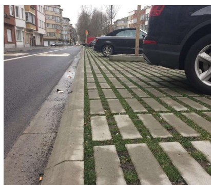
Désimperméabilisation du parking du parc Elie Lotar à Aubervilliers (image de gauche) et désimperméabilisation des sols par l'usage de pavé enherbé (image de droite)
