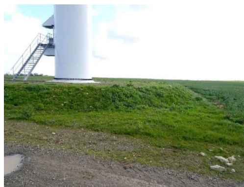
Traitement des socles
