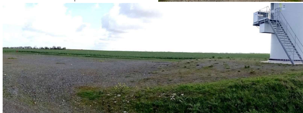
Traitement des plateformes
