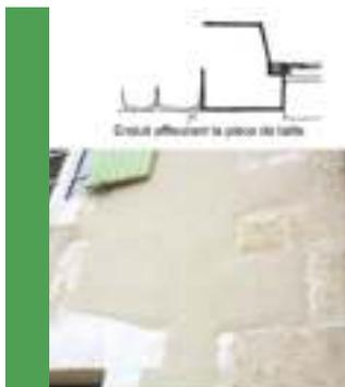
La mise en œuvre de l'enduit, affleurant les pierres d'encadrement et de chaînage : le mortier doit affleurer la surface extérieure des pierres, sans être en surépaisseur.
